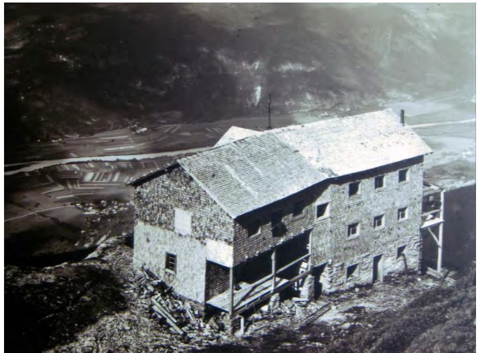
Im Bild die im Umbau befindliche Neuburger Hütte im Frühsommer 1906. Den Großteil der Um- und Erweiterungsarbeiten führt das Telfer Baugeschäft und Sägewerk Vinzenz Kranebitter aus.
