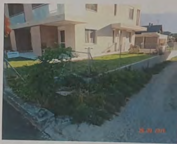
So zeigt sich der abgedeckte Brunnen vor Beginn der Arbeiten zur Wiederaktivierung
