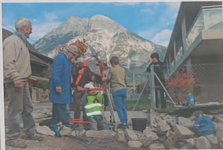
Daniel Kirchmair, der mit einem Bergegerät des Abwassererands Telfs hinuntergeseilt wird, säubert den Brunnenboden von Bauschutt und Unrat.
