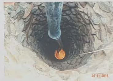
Um tiefer in den Brunnengrund zu gelangen, versucht die Fa. Hopperger mittels Absauggerät den Boden des Brunnens aufzuweichen. Leider gelingt das nicht, weil sich vermutlich eine Schicht Beton am Brunnengrund befindet.
