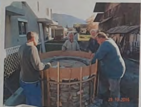
Tischlermeister Anton Poyer und Schmiedemeister Alois Ruef bereiten die aufwändigen Schalungsarbeiten für die Errichtung des Mauerabschlusses und Sepp Schatz die Abdichtung zum Betonieren vor.
