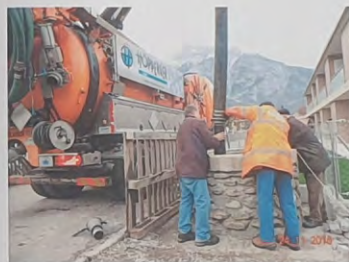
Um tiefer in den Brunnengrund zu gelangen, versucht die Fa. Hopperger mittels Absauggerät den Boden des Brunnens aufzuweichen. Leider gelingt das nicht, weil sich vermutlich eine Schicht Beton am Brunnengrund befindet.
